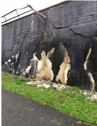
Purtroppo rimangono ancora le tracce di **percolato giallastro** sul muro sottostante la zona di interrimento.
